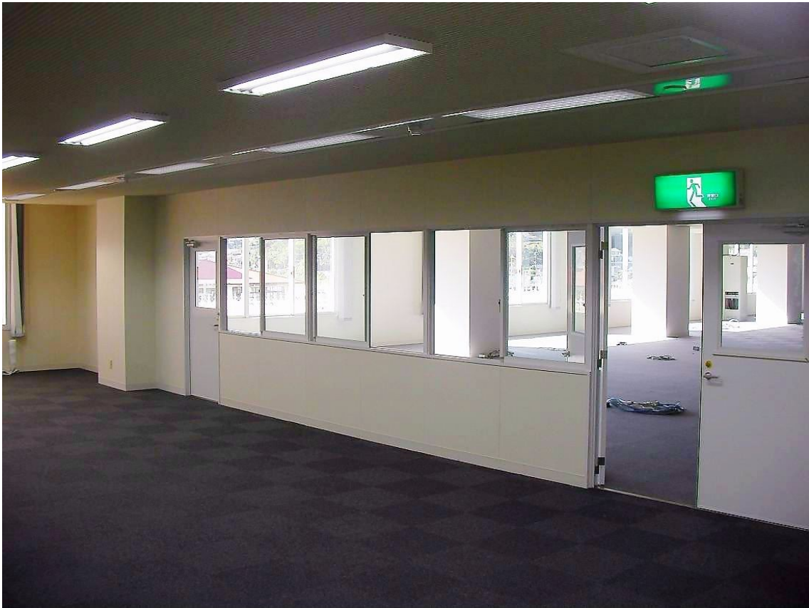
・ 3 F サーバー室
