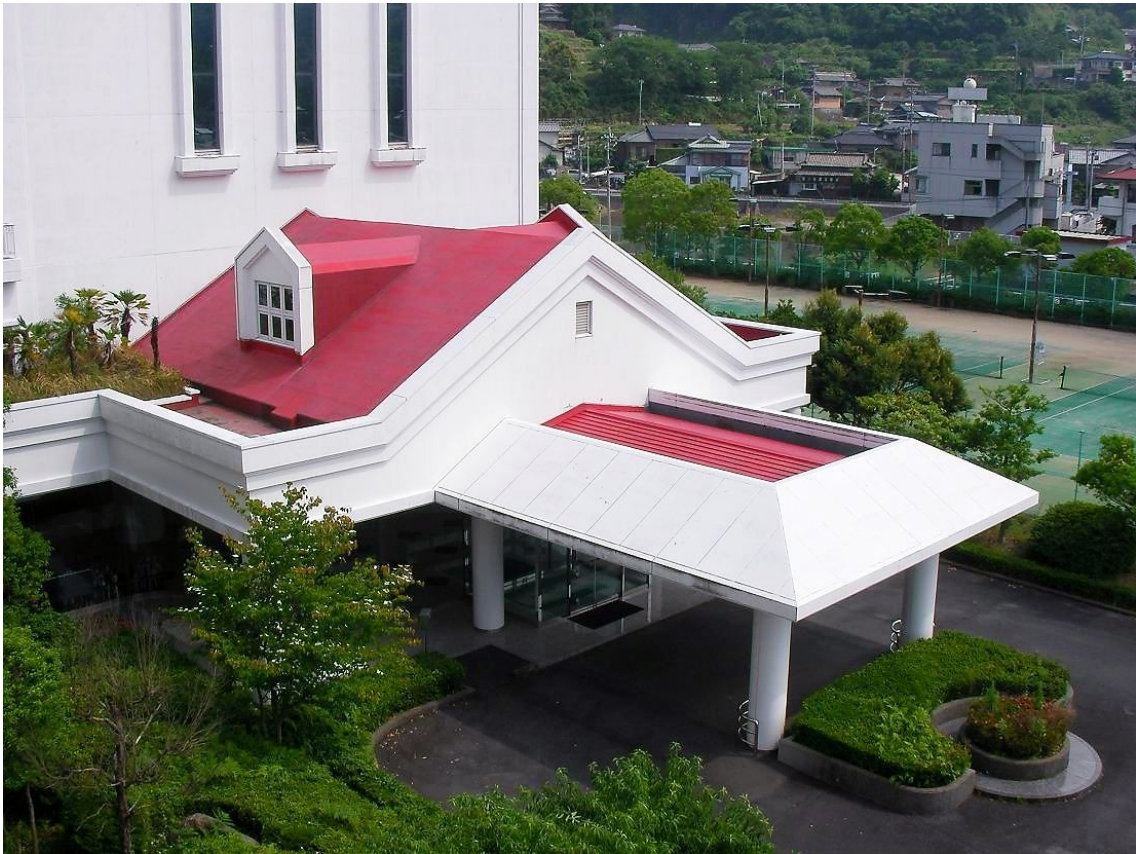
・エントランス外観
